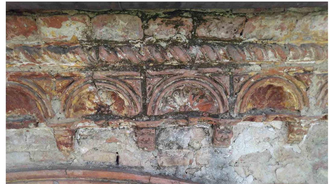
prova di pulitura del trattamento biocida dove è rileggibile l'attacco biologico presente
