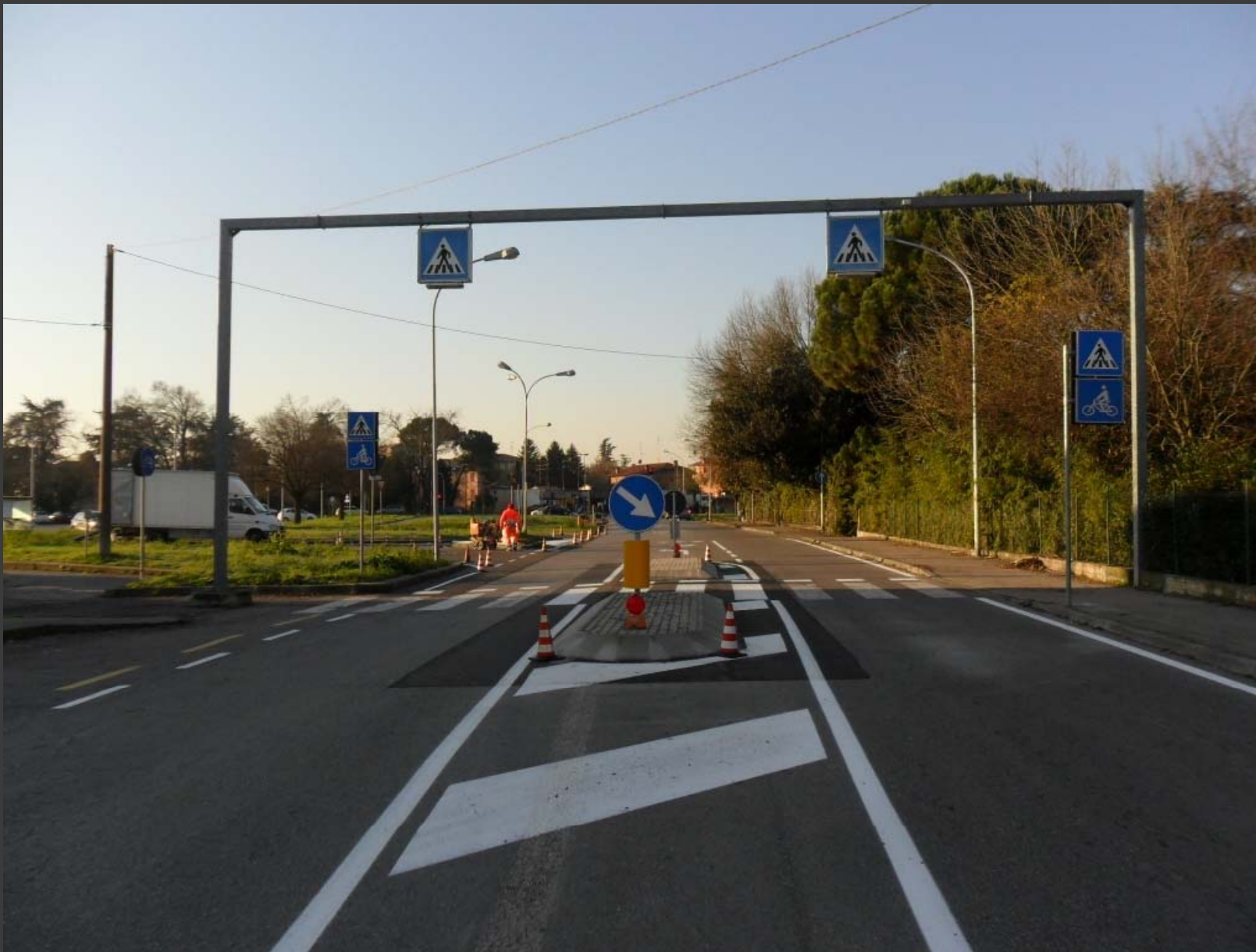
Messa in sicurezza dell'attraversamento ciclopedonale di via Pontegradella a collegamento tra via Malpasso e via Francia
