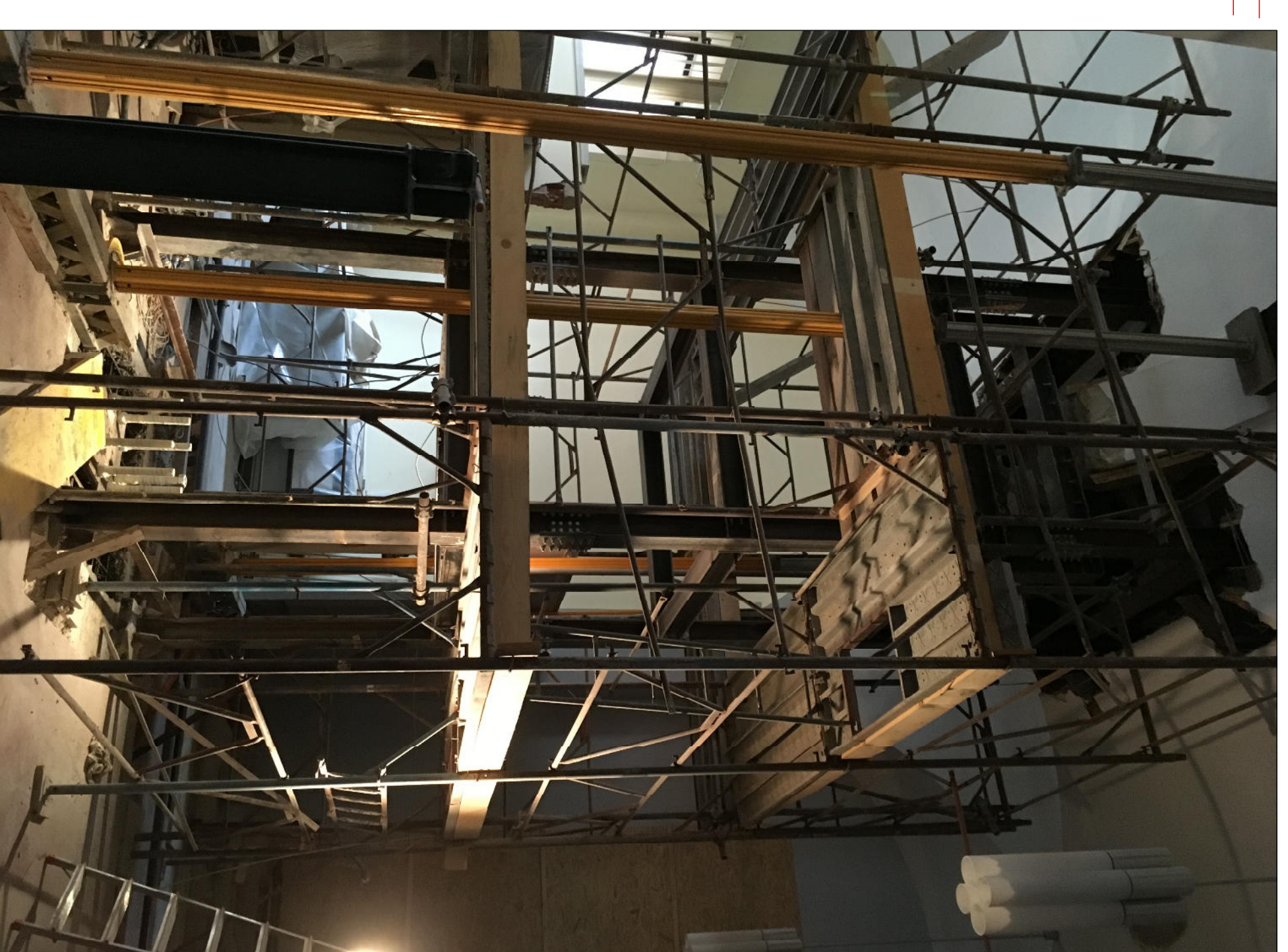
DETTAGLIO PORZIONE INFERIORE TRALICCIO METALLICO PROVVISORIO A SOSTEGNO SOLAIO E ARCHI A LIVELLO DEL PIANO 1° E PUNTELLI A SOSTEGNO ARCHI
