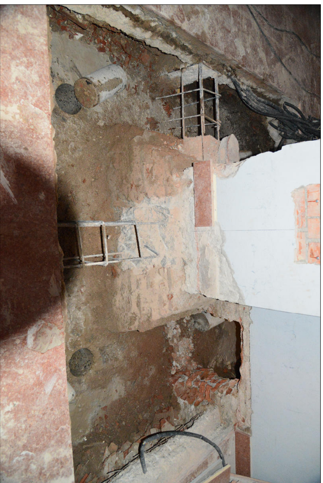
DETTAGLIO SCAVI E DEMOLIZIONI TEMPORANEE ALLA BASE DEI PILASTRI CENTRALI
