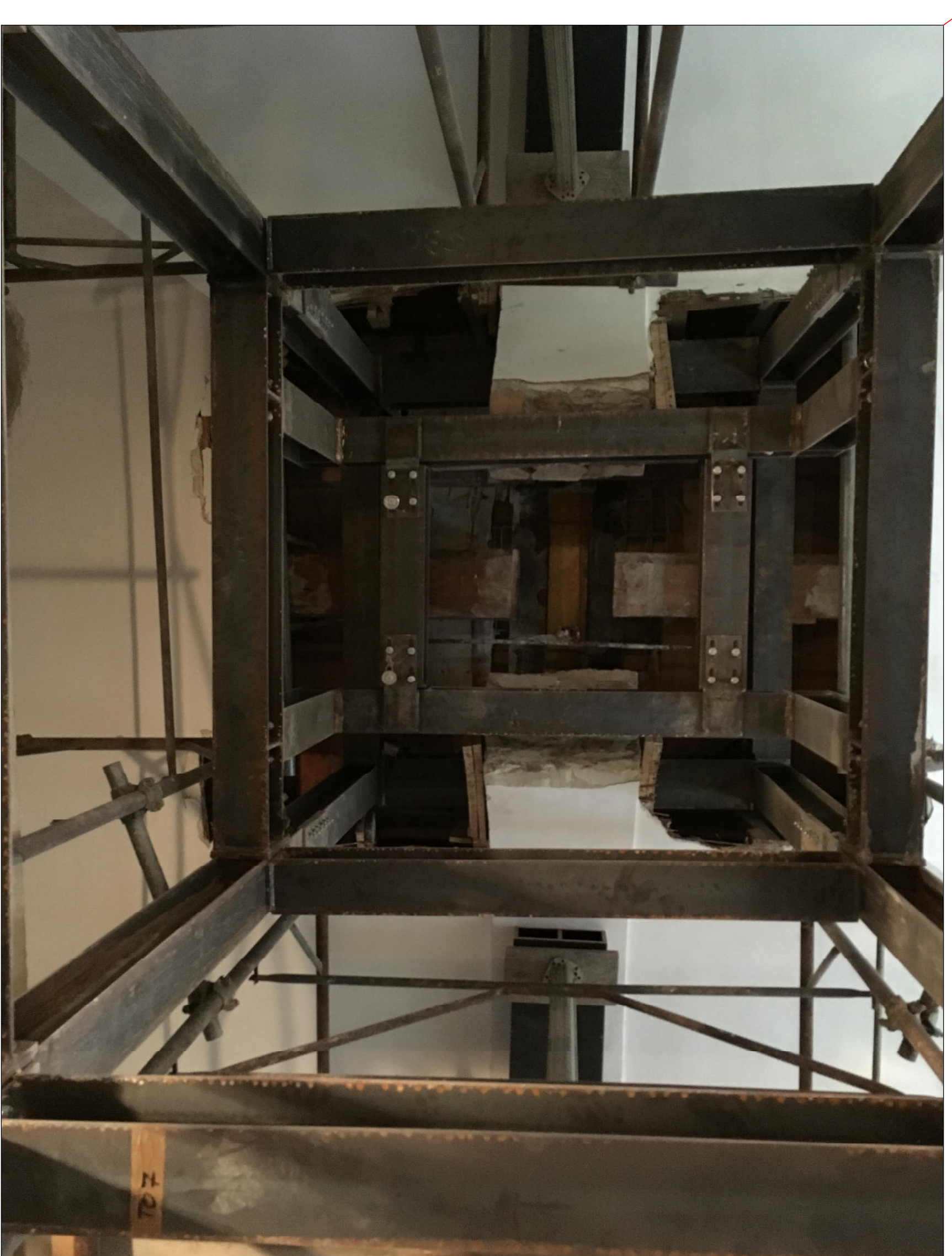
DETTAGLIO PORZIONE INFERIORE TRALICCIO METALLICO PROVVISORIO A SOSTEGNO SOLAIO E ARCHI A LIVELLO DEL PIANO 1° E PUNTELLI A SOSTEGNO ARCHI
