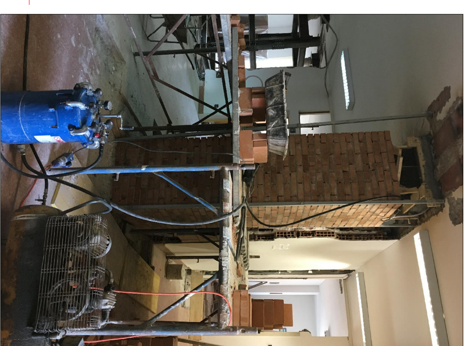
DETTAGLIO RICOSTRUZIONE FINALE RIVESTIMENTO IN MATTONI DELLE COLONNE METALLICHE
