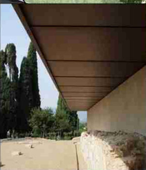
particolare passerella ciclo-pedonale sopraelevata in corten e parapetto in vetro
