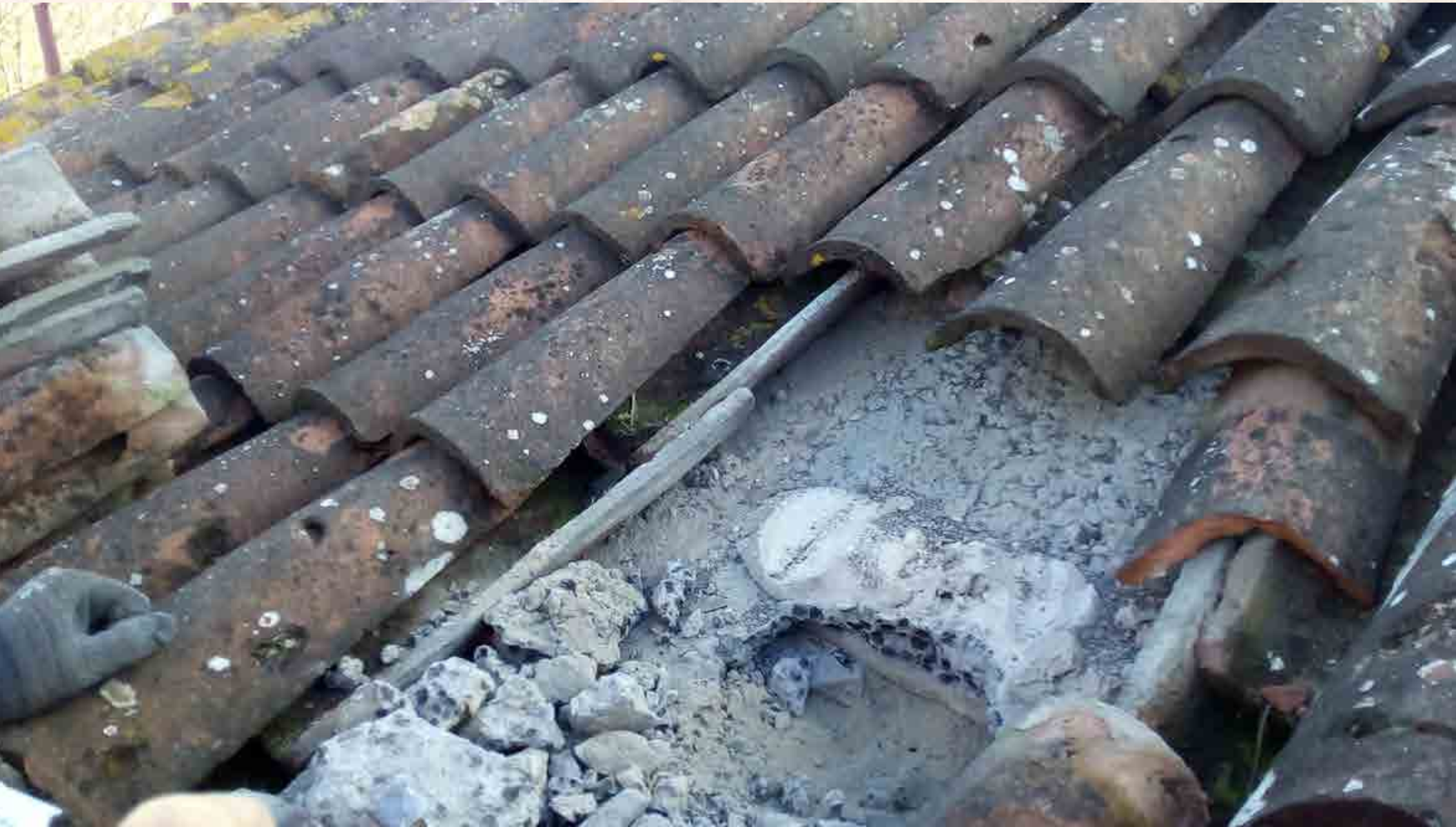
manto di copertura privo di guaina impermeabile e con coppi degradati che favorivano le infiltrazioni di acqua meteorica
