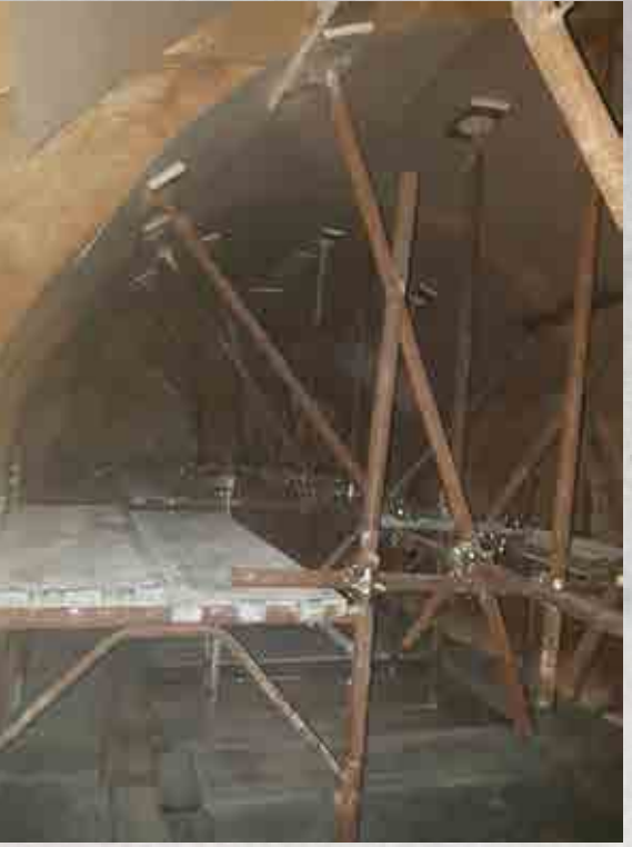
dettaglio delle opere provvisorie necessarie per il lavoro in sicurezza degli operatori
