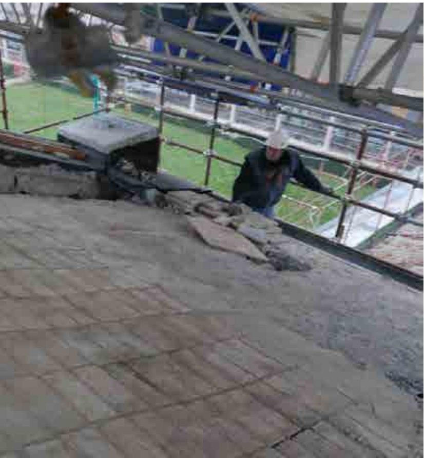
vista della posa del pianellato prima della successiva posa del tavolato
