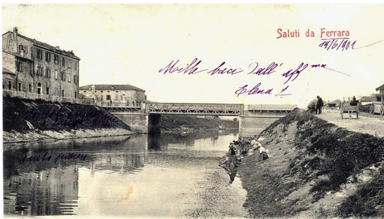
Il Ponte San Giorgio in ferro ad una sola campata, poco dopo la sua costruzione avvenuta tra 1891 e il 1894 (Archivio Alberto Cavallaroni)
