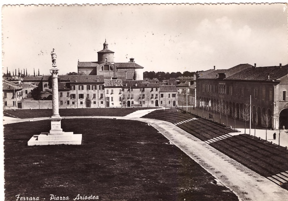
Immagine della piazza al termine dei lavori
