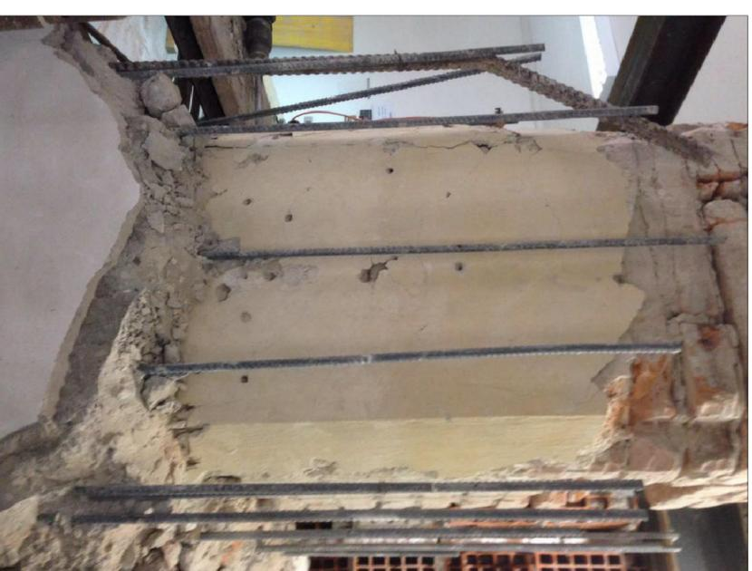
DETTAGLIO ARMATURA RIVESTIMENTO ESTERNO IN C.S. PRESENTE SU ALCUNI PILASTRI
