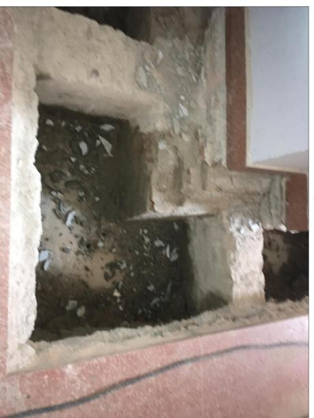
DETTAGLIO TRAVI E PLINTI DI FONDAZIONE ALLA BASE DEI PILASTRI INTERNI
