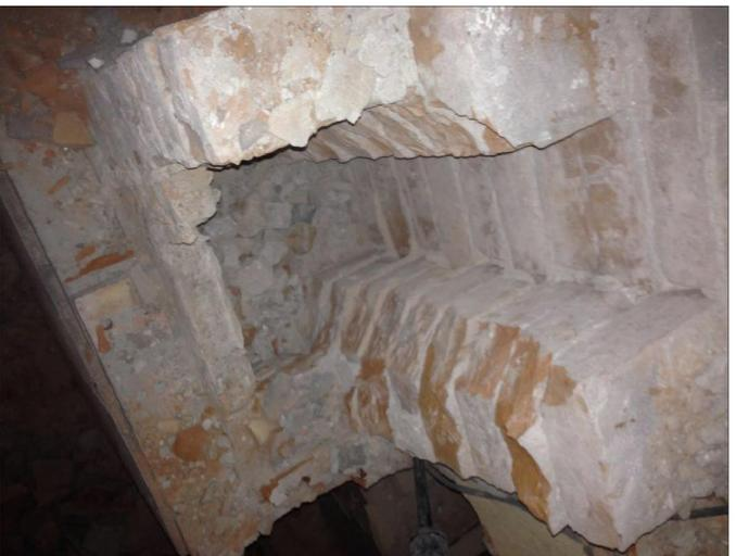
DETTAGLIO STRUTTURA INTERNA PILASTRI ESISTENTI DEMOLITI PRESENTI IN ALCUNI TRATTI AL PIANO TERRA
