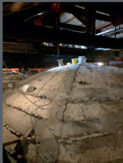
In estradosso: pulizia delle volte, iniezione con geocalce delle lesioni passanti, svuotamento e rifacimento dei rinfianchi, posa della fibra di acciaio e inghisaggio con fiocchi (circa 380 a volta), protezione della volta con una cappetta di geocalce.
