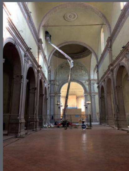
In intradosso rimozione dell'intonaco ammalorato o in distacco; rifacimento intonaco e tinteggiatura a base di calce e pigmenti come esistenti.
