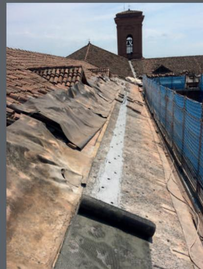
Ripassatura di tutte le coperture alte, sulla navata centrale, transetto, presbiterio, sagrestia, abside e campanile. Realizzazione di cordolo in muratura armata tramite fascia in fibra di acciaio ad alta resistenza e diatoni a fiocco inghisati con malta colabile, rete
