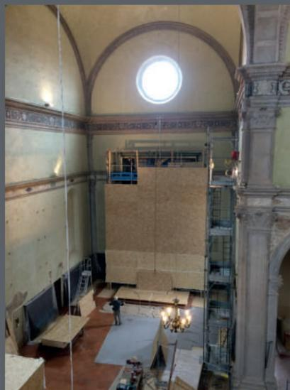
Protezione delle opere d'arte fisse con ponteggi ispezionabili, pannelli antipolvere e datalogger per il controllo della temperatura e dell'umidità. Realizzazione di box per la salvaguardia delle opere d'arte mobili.
