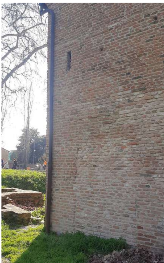
FOTO 11 – Prospetto est in cui sono ben visibili i segni della presenza della porta, ora tamponata
