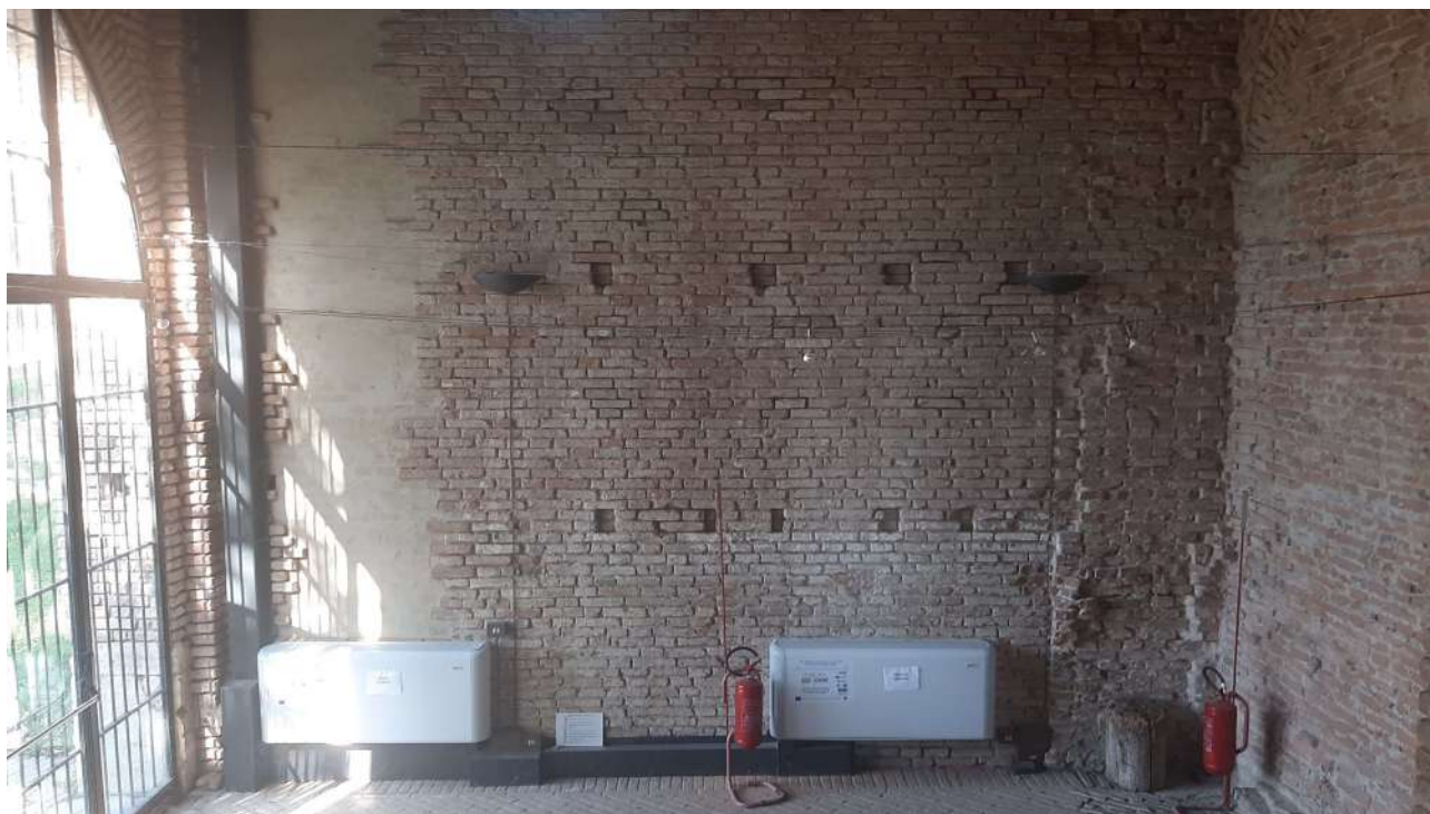
FOTO 8 - Parete ovest sala principale con fancoil a vista – GEO4CIVIC 2021
