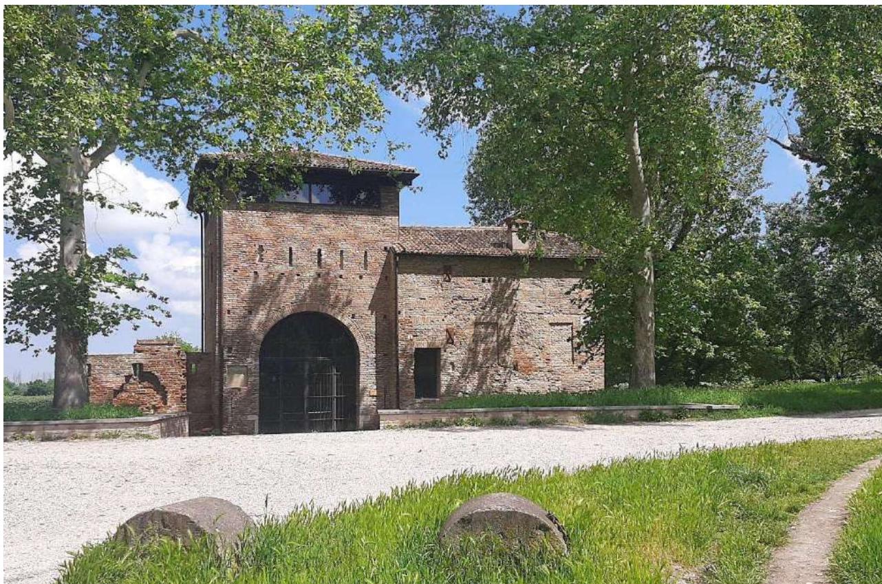
FOTO 1 - Vista dal terrapieno in asse con Corso Ercole I d'Este
