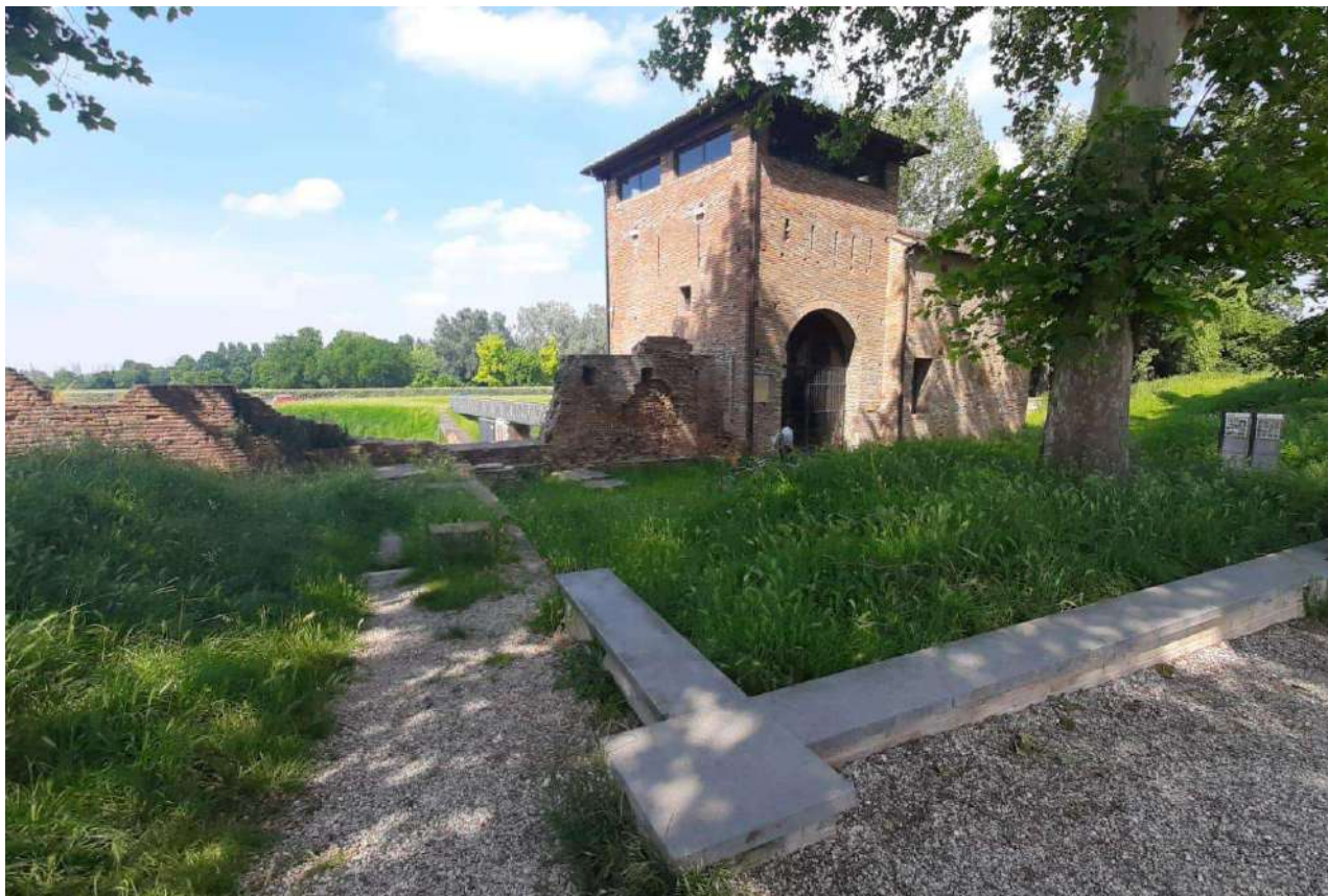
FOTO 9 - Rampa di accesso a ovest dei muri di contenimento
